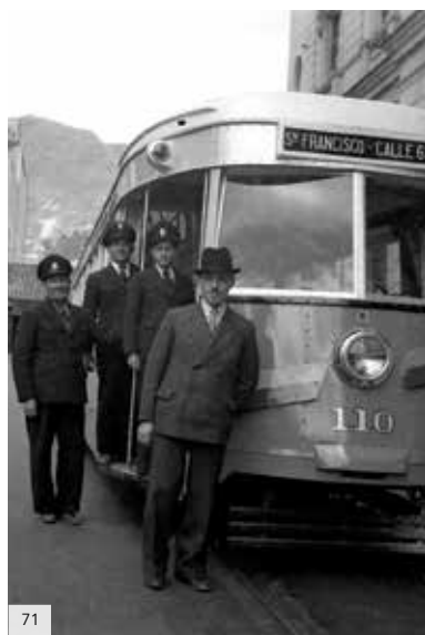
Línea del tranvía, ruta San Francisco - Calle 67, Parque Santander / ca. 1945 / Daniel Rodríguez
