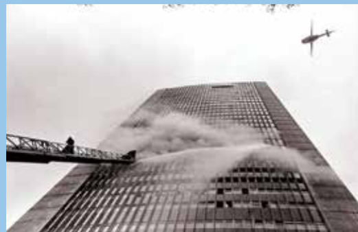
Incendio del edificio Avianca/ 1973/ Manuel H
