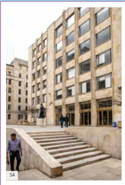
Edificio Manuel Murillo Toro / 2015/Margarita Mejía-IDPC
